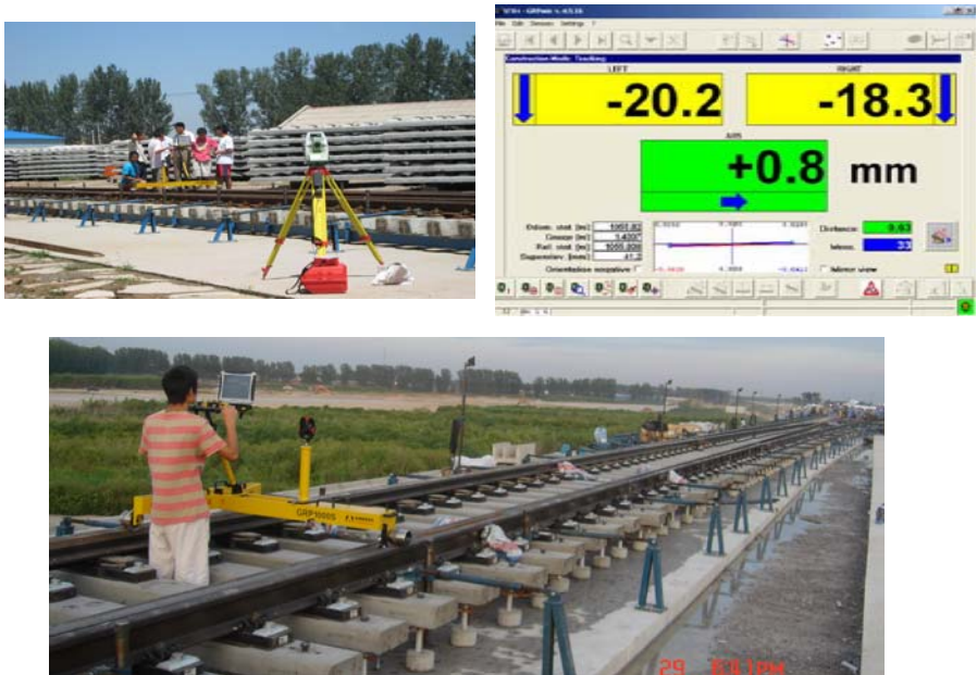
说明图 9.5.6 全站仪自由设站与轨道几何状态测量仪进行道岔精调
