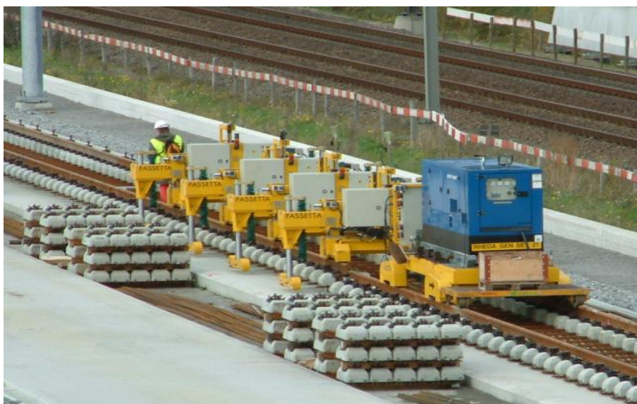
说明图 9.4.3-1 采用全站仪自由设站配合粗调机进行轨排粗调
