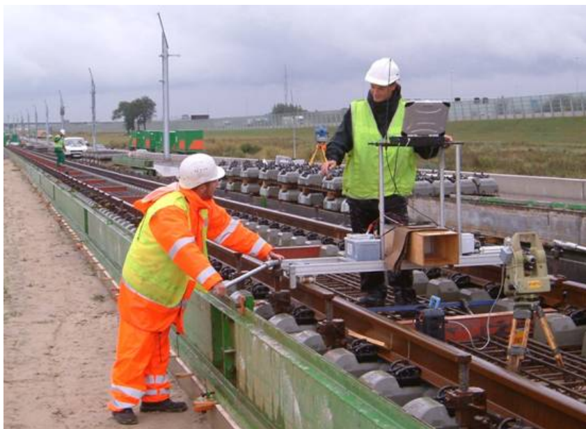
说明图 9.4.3-2 全站仪自由设站配合轨道几何状态测量仪测量进行轨排精调
