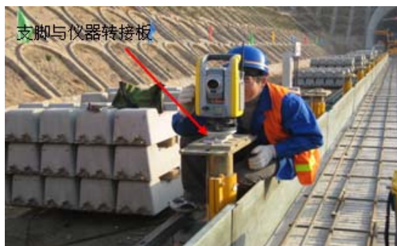
说明图 9.4.4-1 全站仪在支脚上精调设站
